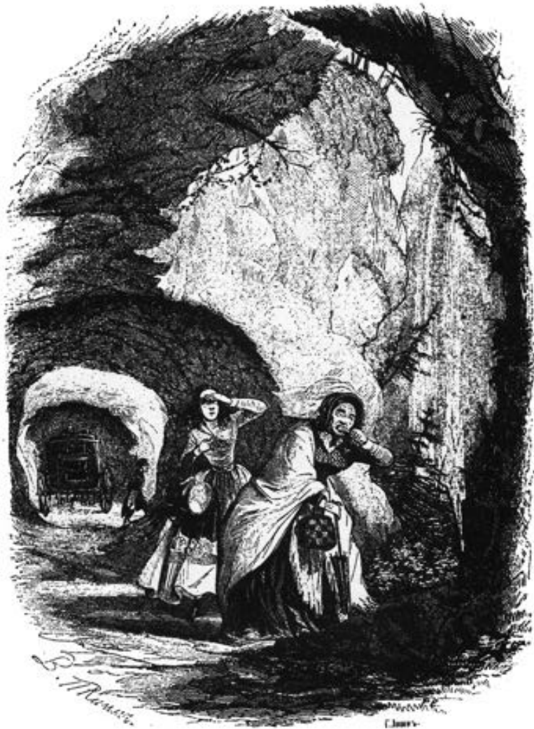
Galerie der Simplonstrasse. Illustration von W.F. Timm zu einem russischen Reiseroman in Versen von I.P. Mjatlew, dessen 2. Teil über die Schweiz 1843 erschienen ist. Die Abbildung zum Anfang des Kapitels Simplon stammt aus einer Werkausgabe Mjatlews, Moskau 1894
